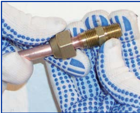
Slika 8: Pozicioniranje elemenata spojnice
