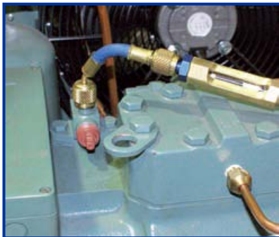
Slika 15: Test ulja na usisnoj liniji kompresora
