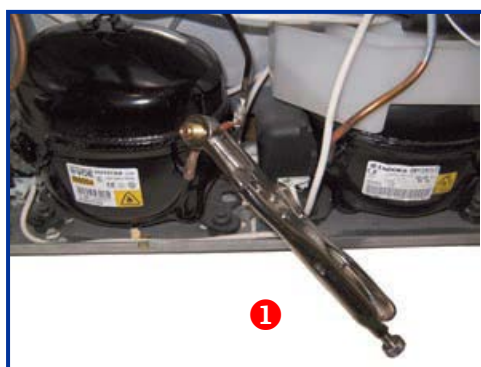
Slika 7: Postavljanje kliješta sa ubodnim priključkom na servisnu cijev
