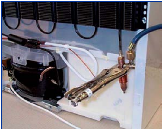
Slika 8: Postavljanje dodatnih kliješta sa ubodnim priključkom
