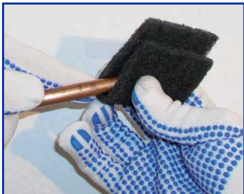
Slika 3: Čišćenje površine
