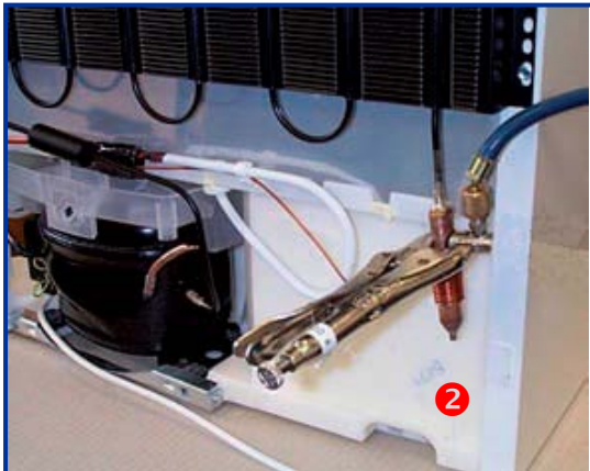
Slika 8: Postavljanje dodatnih kliješta sa ubodnim priključkom
