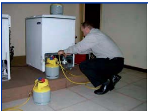
Slika 23: Postavljanje cilindra za prikupljanje
